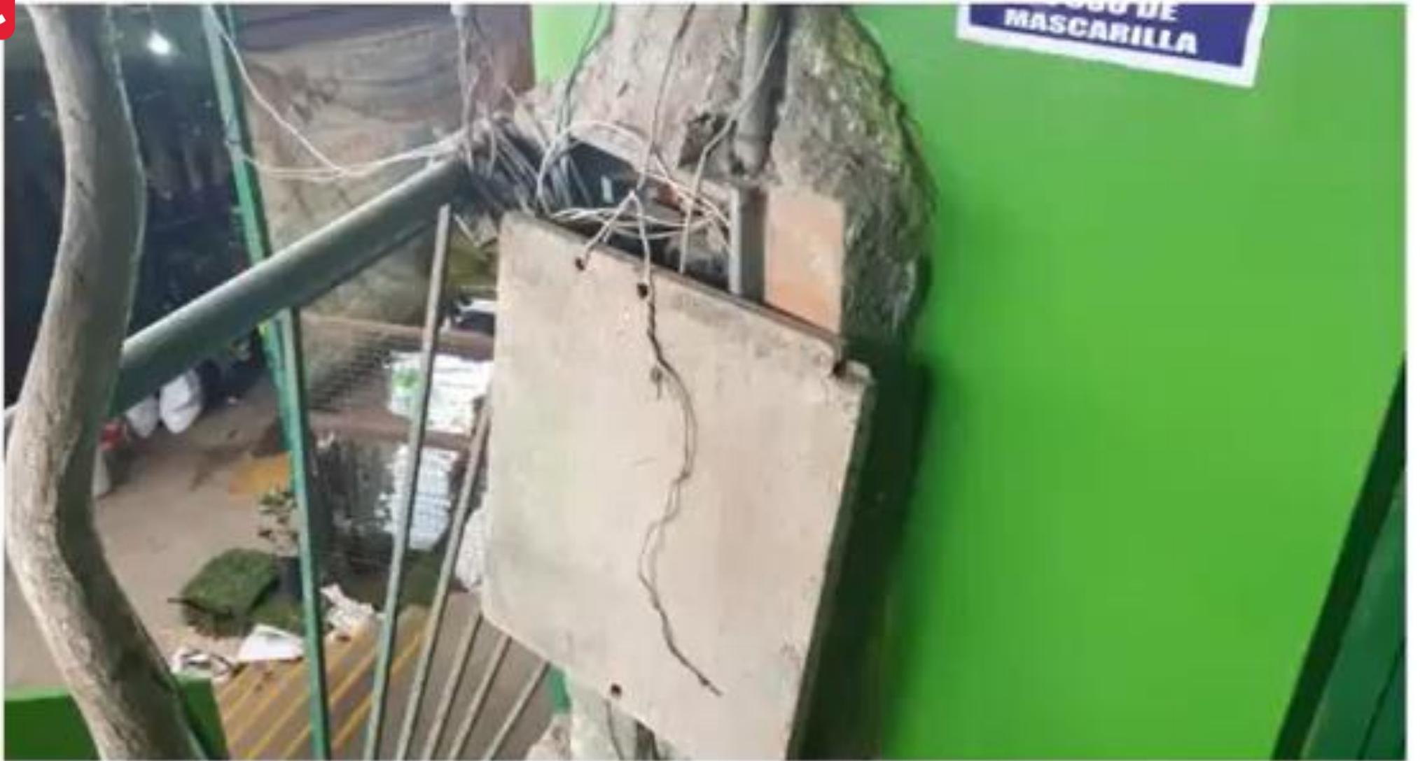
*Ilustración 2.- Tablero Eléctrico General ubicado en el segundo piso, llega un cable alimentador de 3-1x16mm<sup>2</sup> THW, tiene informalmente una tapa de madera que está prohibida(16.09.2022, 10.00 am).*
