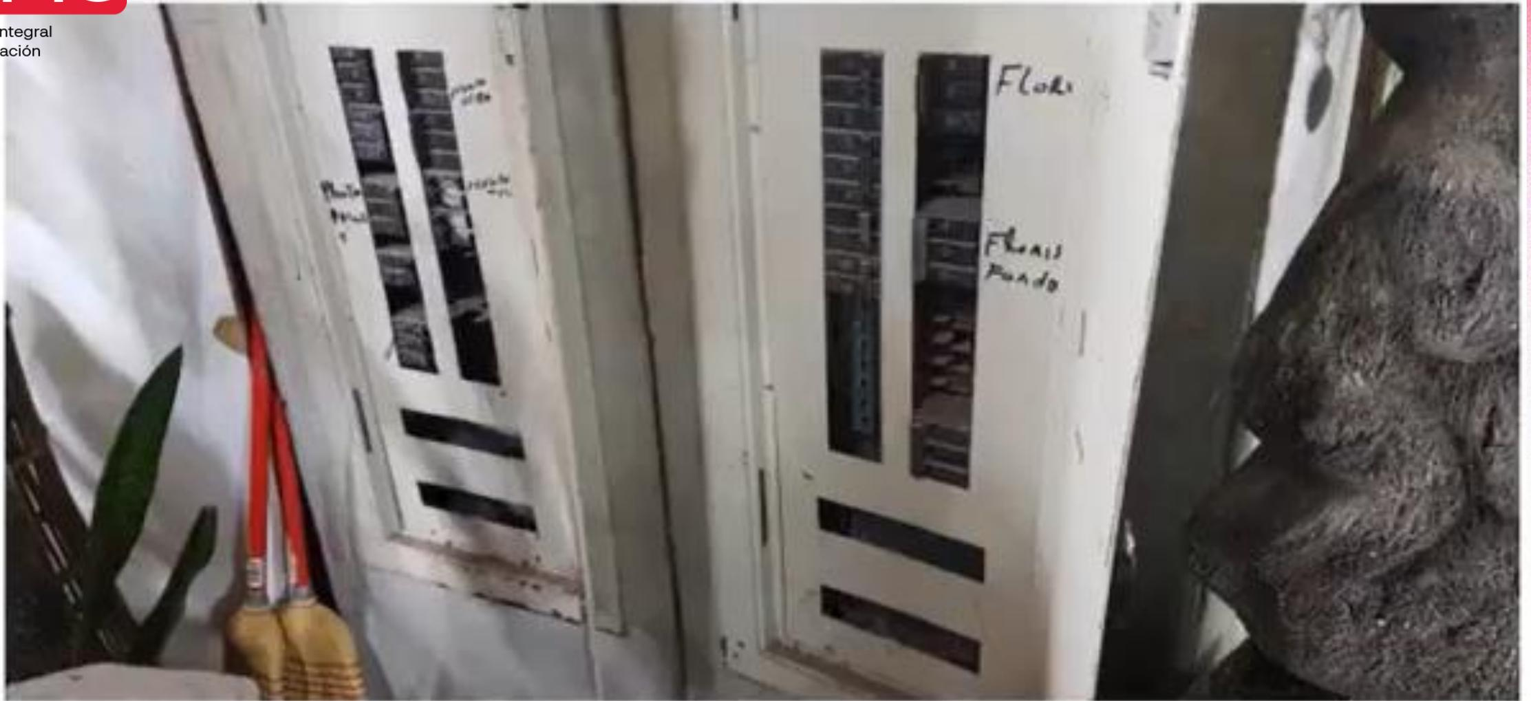
*Ilustración 6.-Tableros Eléctricos TF-2 y TF-3 sin interruptores diferenciales, con mercadería que impide el libre acceso (Fecha: 16.09.2022, Hora: 10 am).*
