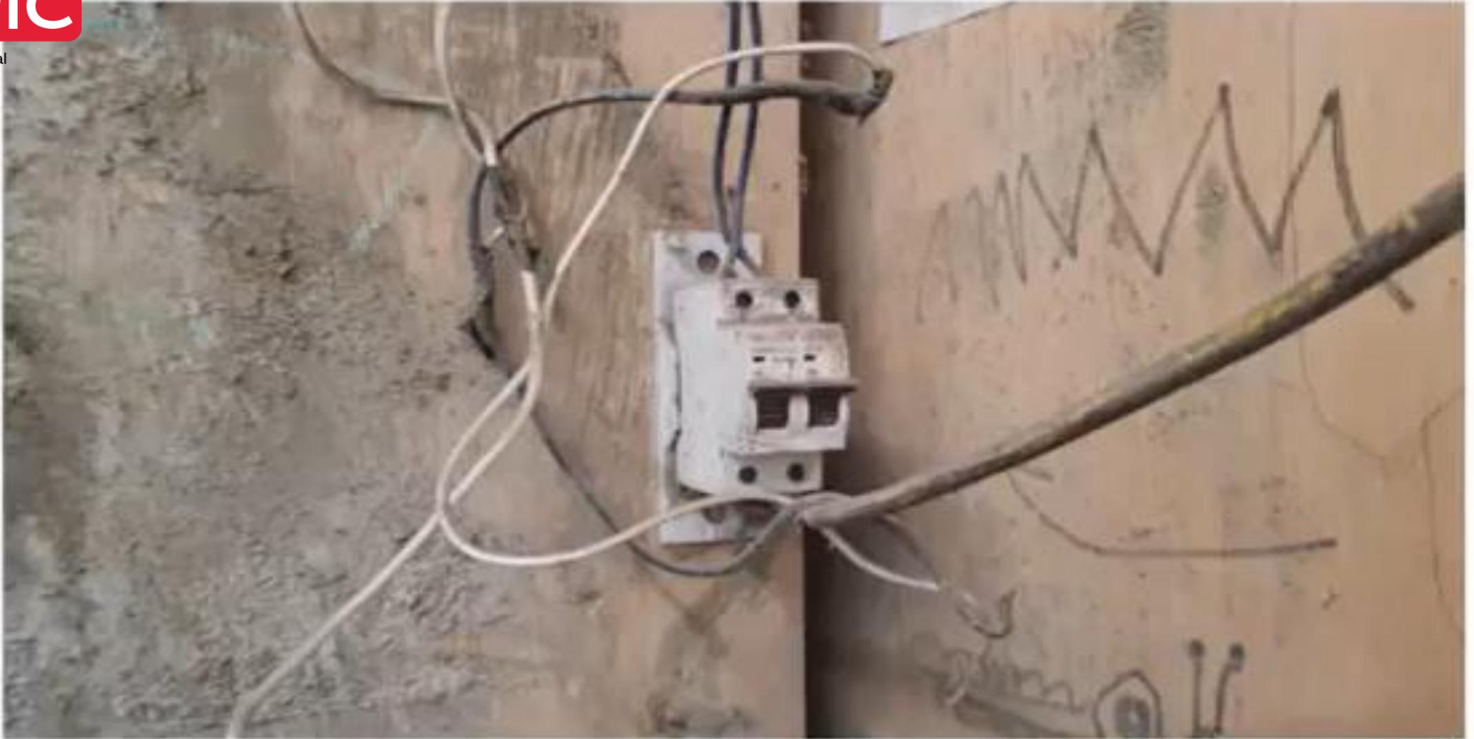
*Ilustración 12.-Interruptor termo magnético que alimenta a circuitos de alumbrado y tomacorrientes sin protección de cables eléctricos y conexiones eléctricas (Fecha:20.09.2022, Hora:10.36 am).*
