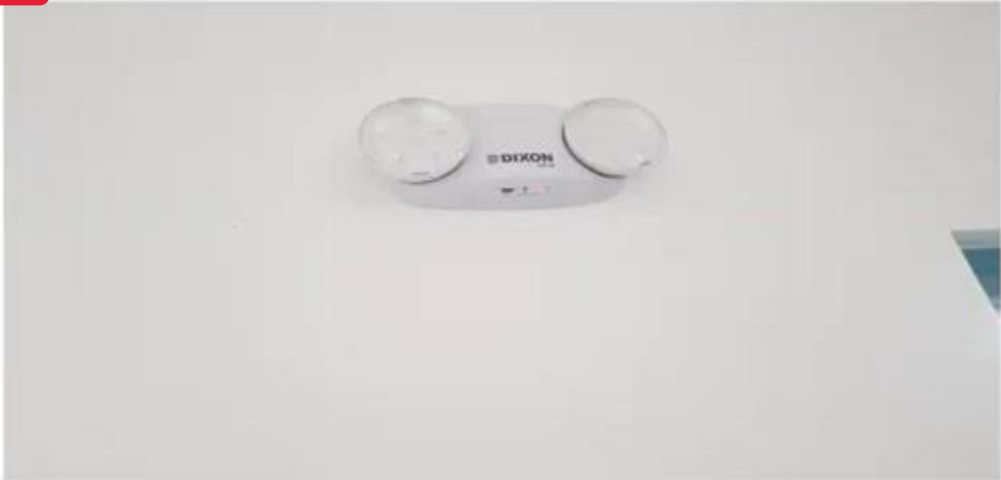
FOTOGRAFIA 3.- EQUIPO LUMINARIA DE EMERGENCIA MARCA DIXON TIENE UNA POTENCIA NOMINAL DE 2.40 W (FECHA: 18.11.2022 HORA: 10:50 AM).
