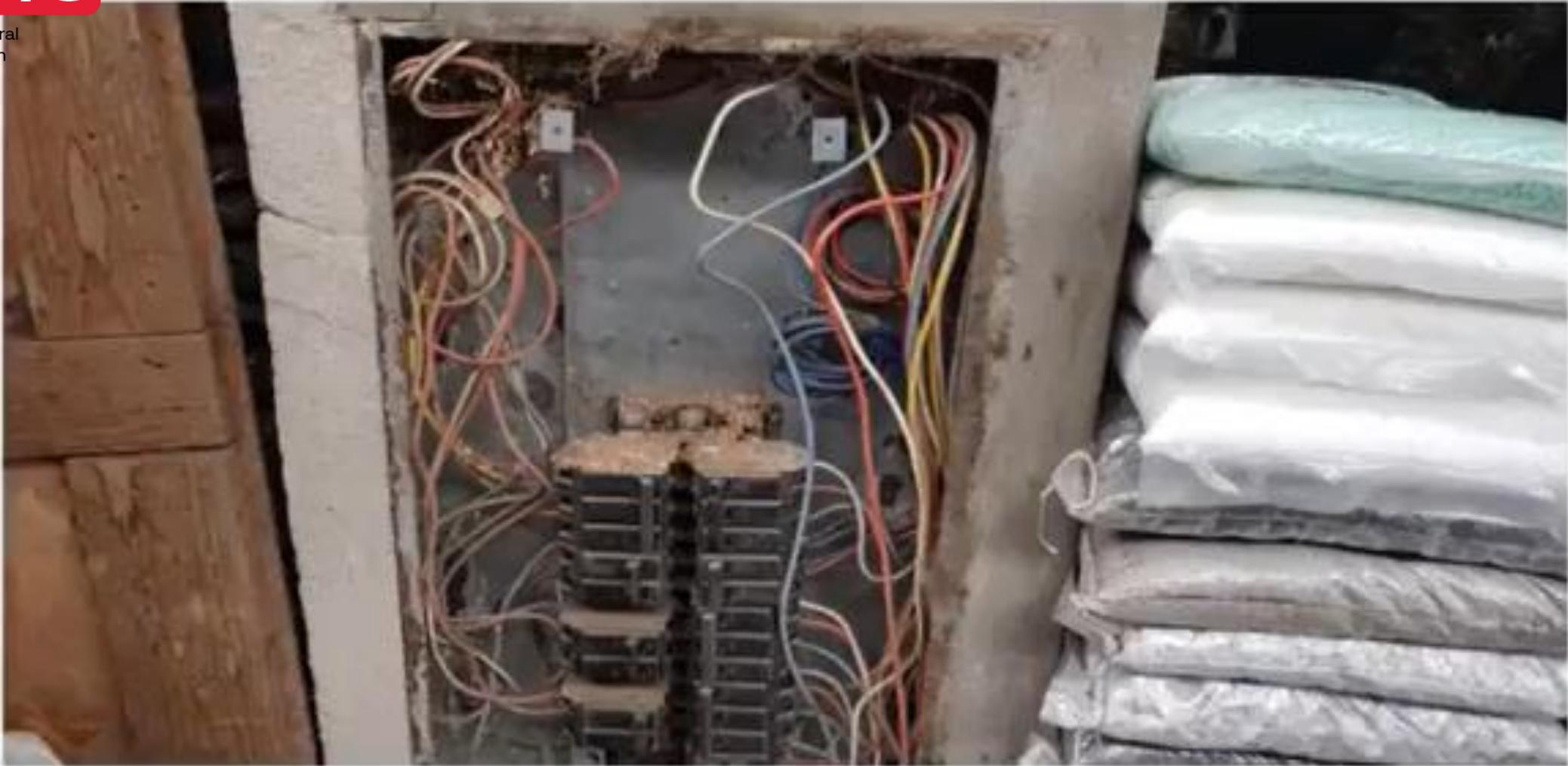
*Ilustración 10.- Conductores eléctricos del Tablero TF-1, se midió el nivel de aislamiento de sus circuitos y están en el orden de 8,5 Megohmios (Fecha: 20.09.2022, hora: 10.20 am).*
